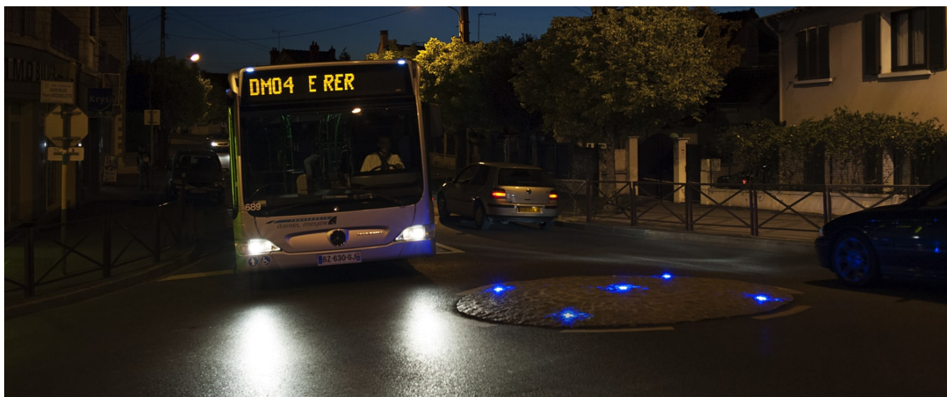
Mini-giratoire LED franchissable. Balisage de sécurité d'un mini-giratoire franchissable par des véhicules en centre-ville à Viry-Châtillon. Plots routiers encastrés très basse tension ECO-870 (24 LED bleues fixes visibles à 360 degrés). Photographie : Karolina Samborska.
