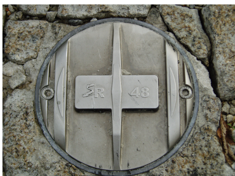
Exemple de balisage de passage-piéton sur un axe routier en zone urbaine
