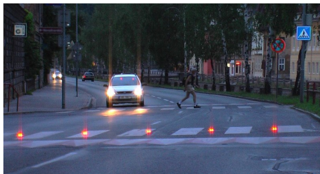
Exemple de balisage de passage-piéton sur un axe routier en zone urbaine
